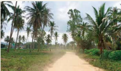
バーンジンジャイへ続く道は未舗装のままでした。
