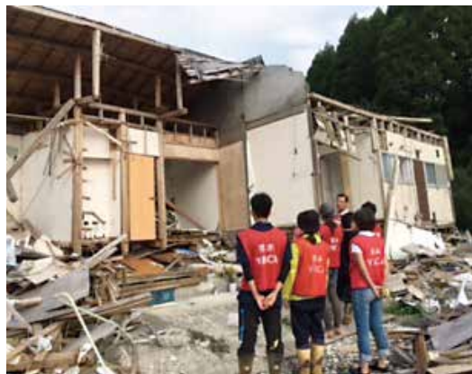
熊本地震で学生が亡くなった2階建てアパート
